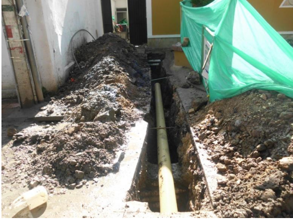
Mantenimiento redes sanitarias
